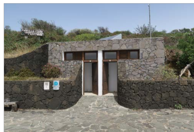
fotografía de fachada.
